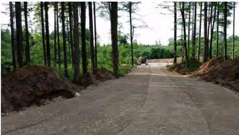
Für den eigentlichen Standort einer Windenergieanlage muss eine Fläche von ca. 3 500 qm gerodet werden. Da die Neigung dieser Fläche auf <1% begrenzt ist, müssten aufgrund der Topografie bei den Standorten im Wald erhebliche Eingriffe in Form von Gelände nivellierungen durchgeführt werden. Die ausgebauten Zufahrten und Kranflächen müssen dauerhaft bleiben, da WEA gewartet und repariert werden müssen.
